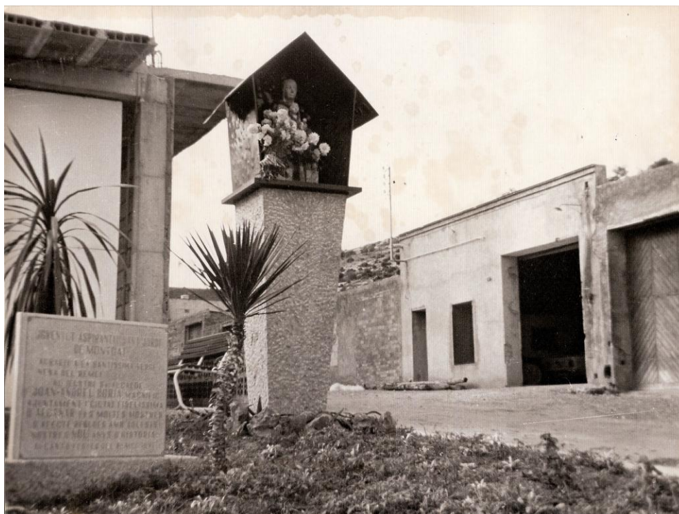
Primera instal·lació a l'entrada d'Alcanar.
